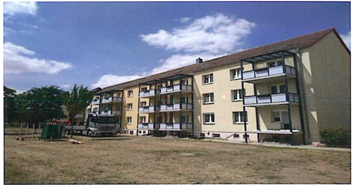
Montage von Balkonanlagen Heinrich-Böll-Straße
