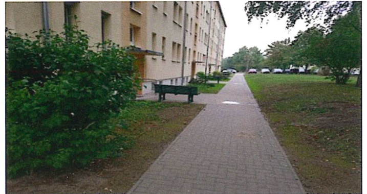
Erneuerung Gehwege Heinrich-Heine-Straße
